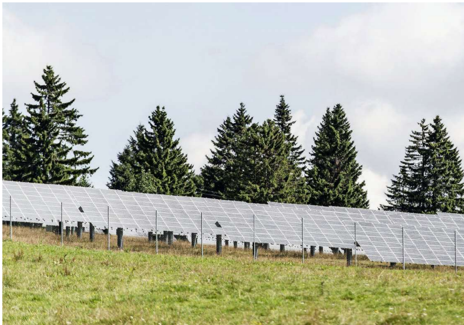
Die Wirtschaftsvertreter sind sich uneins, was die Zukunft der Energiegewinnung angeht: Fotovoltaikanlage auf dem Mont Soleil. Foto: Christian Beutler (Keystone)
