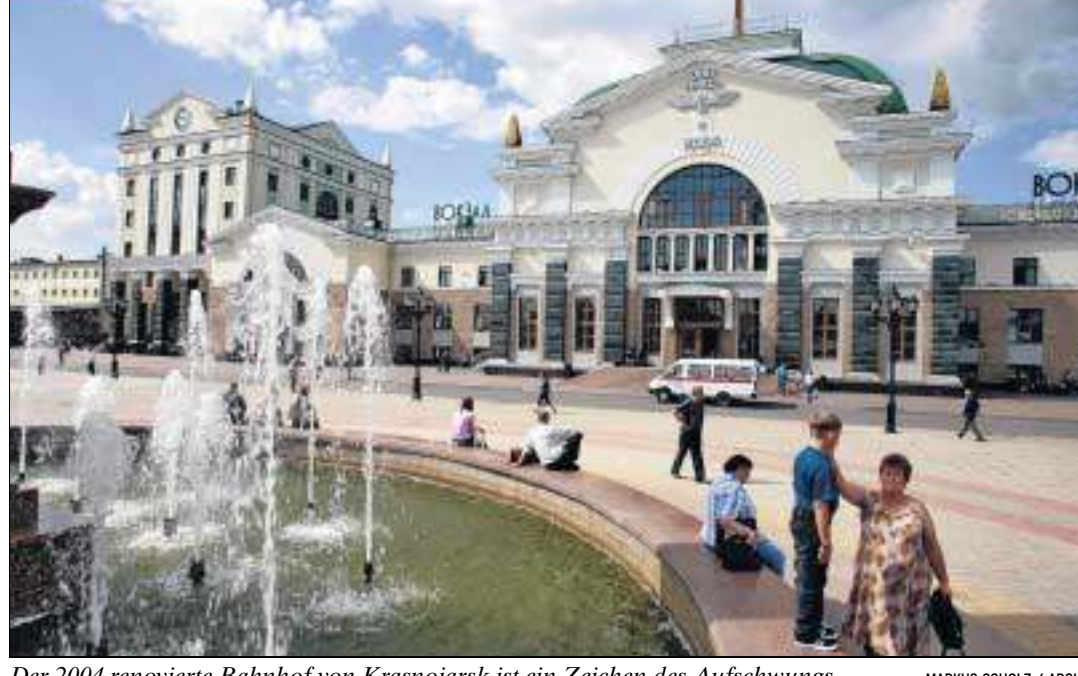
Der 2004 renovierte Bahnhof von Krasnojarsk ist ein Zeichen des Aufschwungs.
